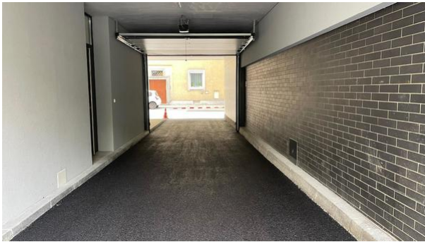
Zufahrt mit elektr. Garagentor
